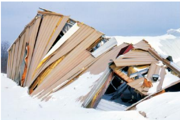
Könnyűszerkezetes építmény összerogyása hóterheléstől [9]
