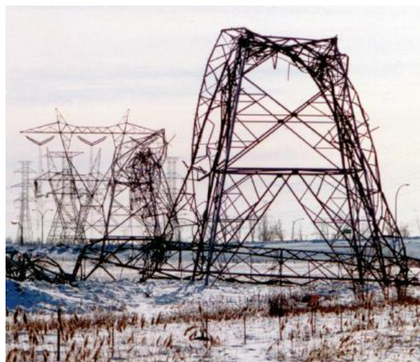
Összerogyott légvezeték tartó oszlopok [9]
