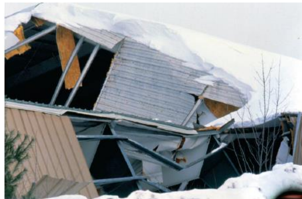
Könnyűszerkezetes építmény összerogyása hóterheléstől [9]
