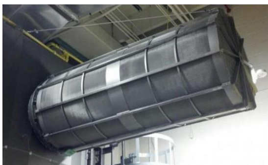
2. ábra – lángmentes lefűvató berendezéssel szerelt porleválasztó
