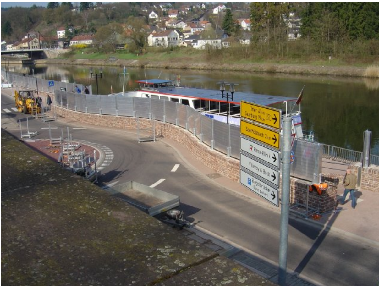
4.1. ábra: BAUER-IBS árvízvédelmi fal
