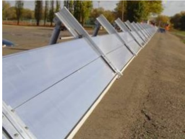
4.3. ábra: Aqua-Barrier árvízvédelmi rendszer
