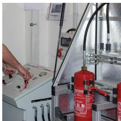
Tartályok nyomáspróbázása (a palástba beütött érték szerint)
