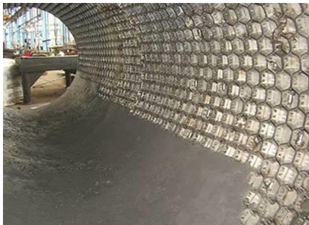
11. ábra: Tűzálló bevonat (Forrás: www.refractorylining.net )
