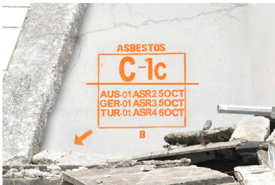
22. ábra: Törökország 01, miután befejezte az ASR 4 teljeskörű SAR-t a munkaterületen, megállapította, hogy ezen a munkaterületen nincs szükség további munkára.
