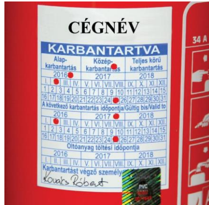
Karbantartást igazoló címke felhelyezése OKF azonosító jellel
