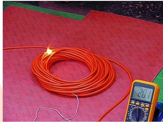
2. Kép Túlterhelt elektromos hosszabbító kábel túlmelegedése, meggyulladása.
